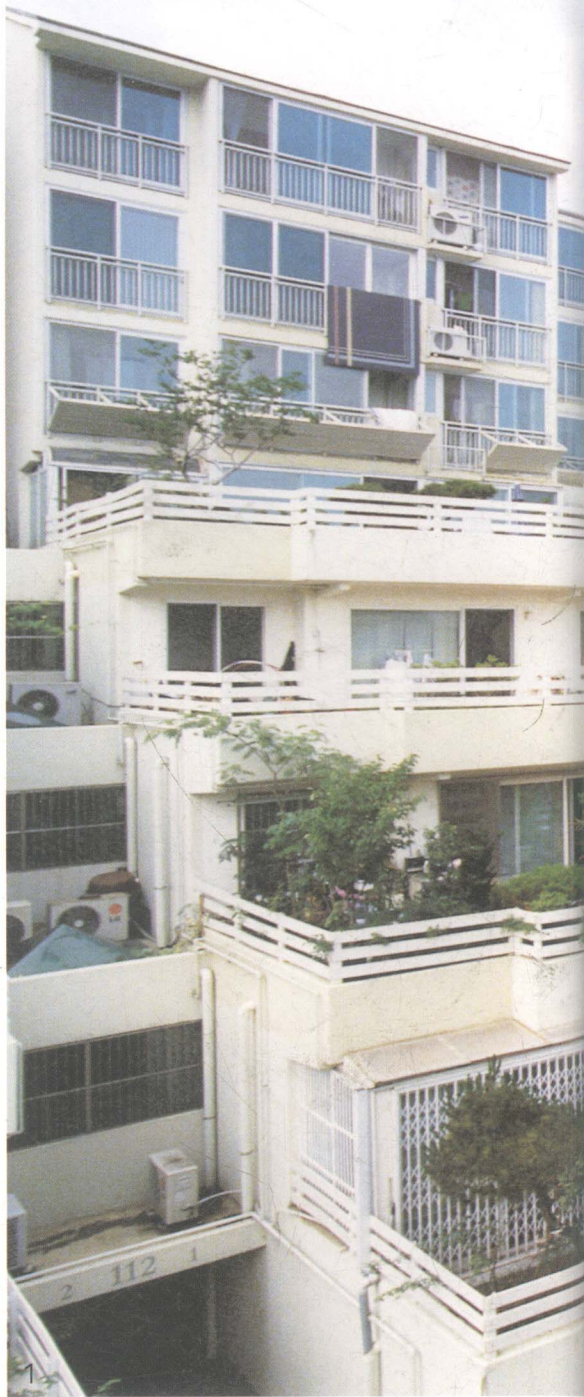
图1：阶梯型房屋全景。充分利用楼与楼之间的较大空间，将房屋建造成阶梯型，并当做造景空间来装点，并且，可以在每座住宅的内部按主人的喜好进行富有个性化的设计
