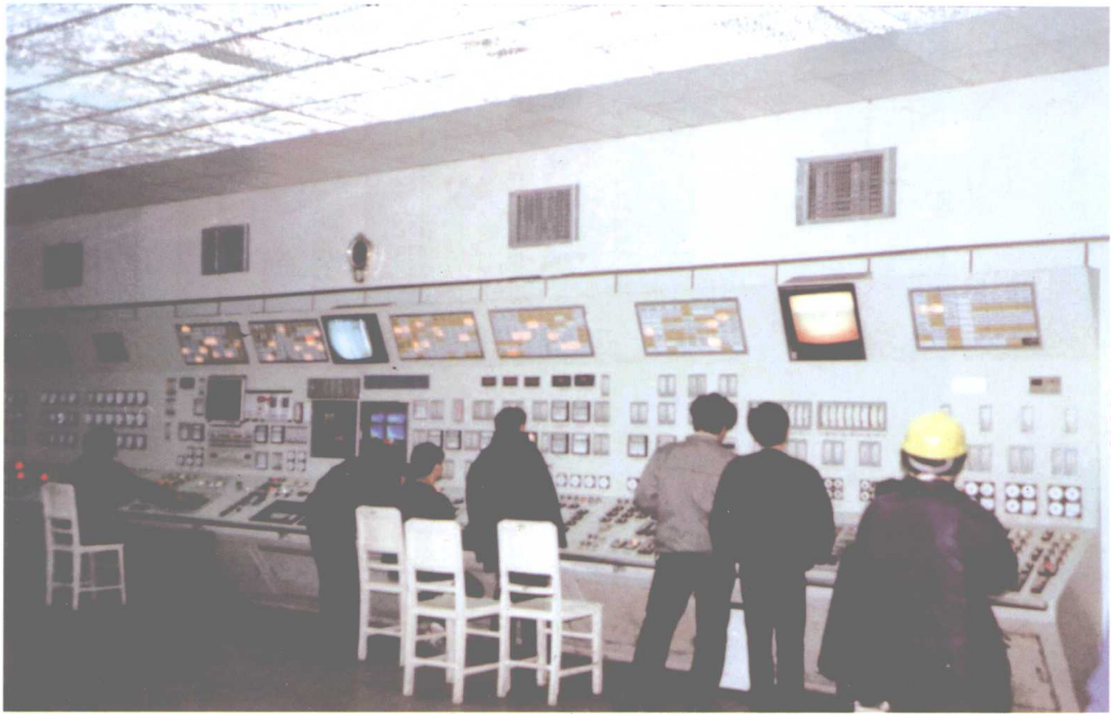
图5 1990年投产的汉川电厂引进型 2 \times 300\text{MW} 机组 索拉-16 (DAS) +SPEC-200 (MCS) +DEH- II
