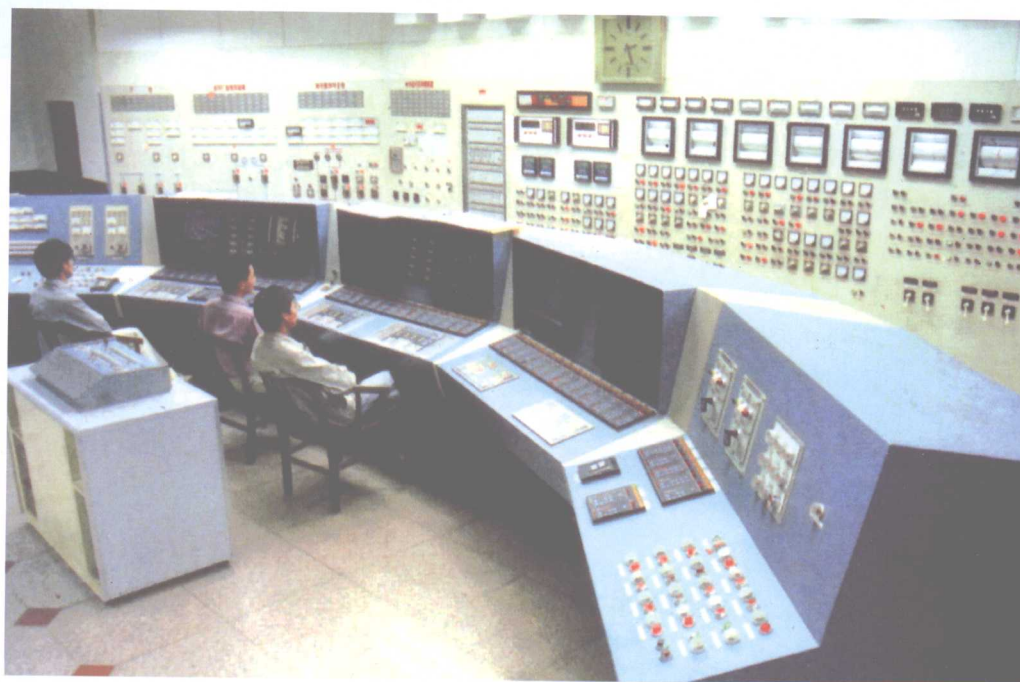
图4 1989年投产的望亭电厂#14机组 (300MW)
