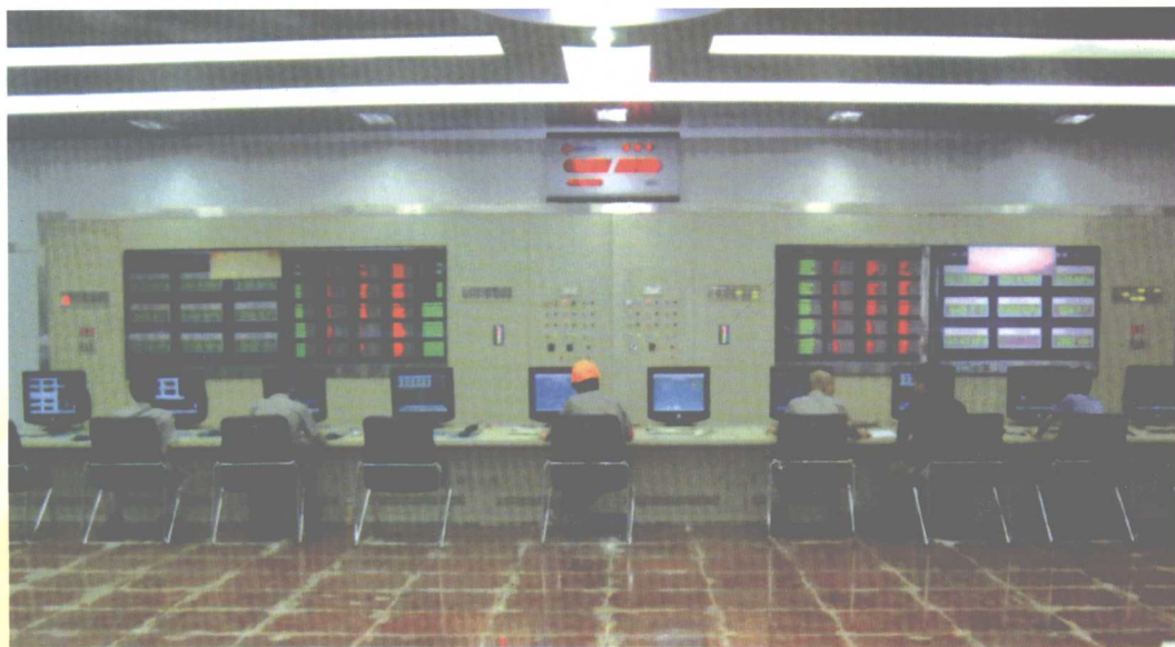
图8 2002年改造后的湖南石门电厂 2 \times 300\text{MW} XDPS-400 (DAS、MCS、FSSS、SCS、DEH、MEH、BPC)
