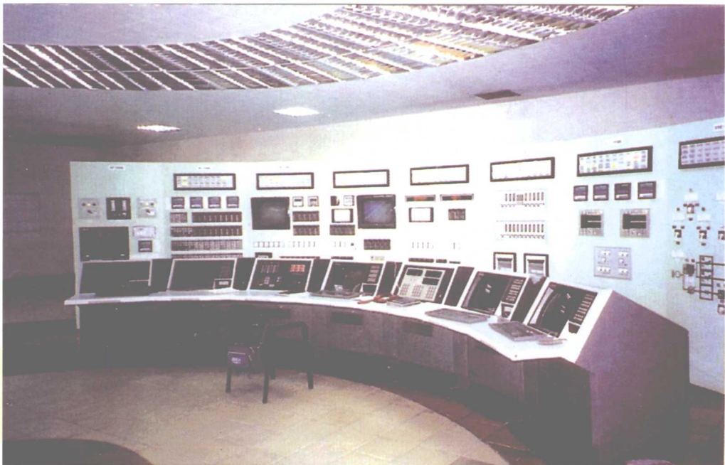
图6 1993年投产的深圳妈湾电厂#1机组 (300MW) infi-90 (DAS、MCS、SCS、FSSS、DEH、MEH)
