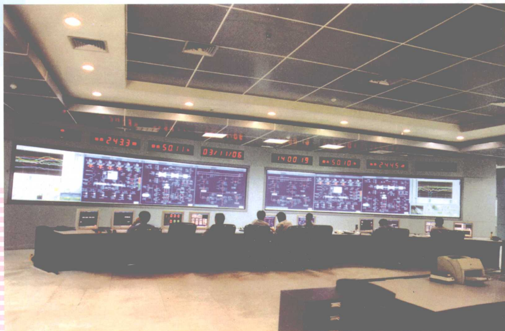
图10 2003年投产的深圳妈湾电厂#5、6机组 ( 2 \times 300\text{MW} ) XDPS-400 (DAS、MCS、SCS、FSSS、DEH、MEH、ECS、BPC)
