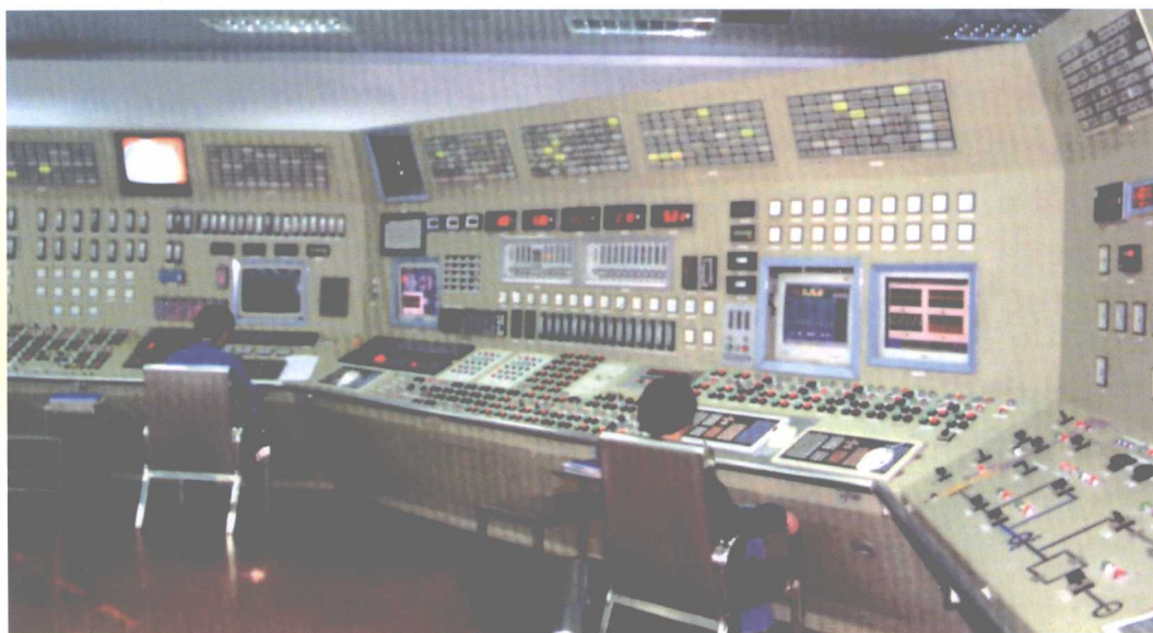
图7 1996年投产的湖南石门电厂 2 \times 300\text{MW} EDPF-2000 (DAS) + infi-90 (MCS、FSSS) + DEH-II、MEH
