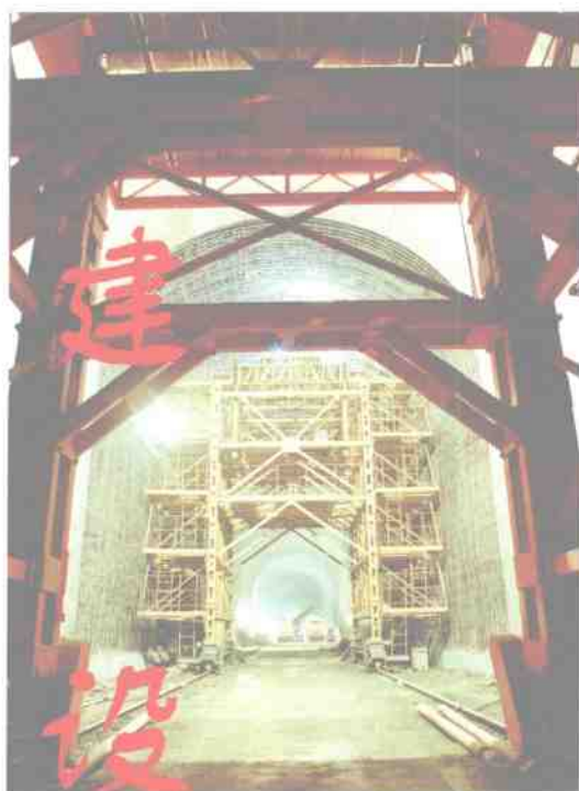
建设中的黑河金盆水库导流洞工程
