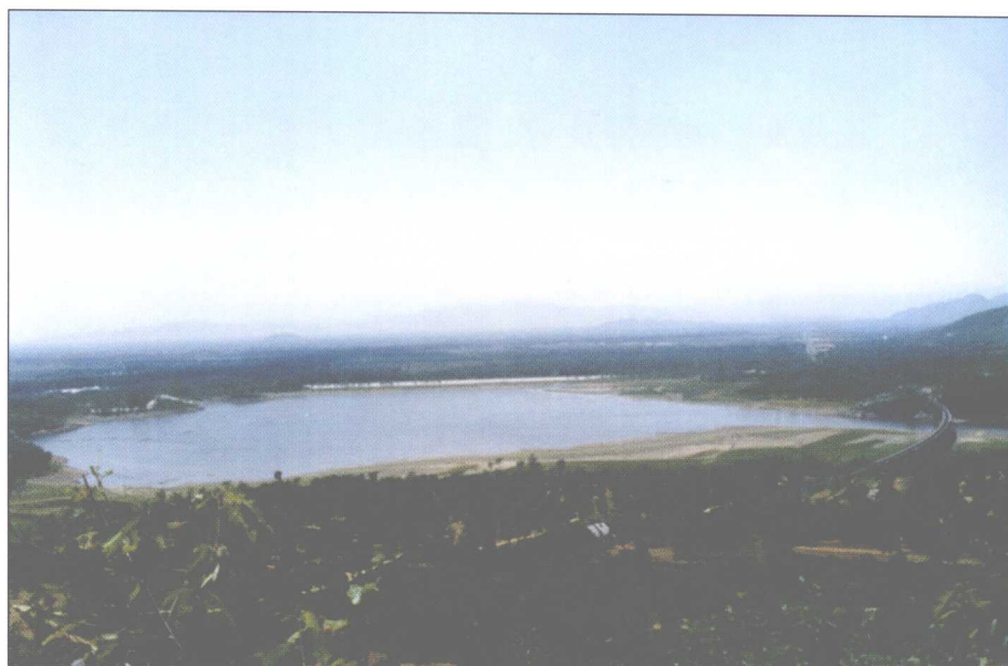
桃峪口水库全景
