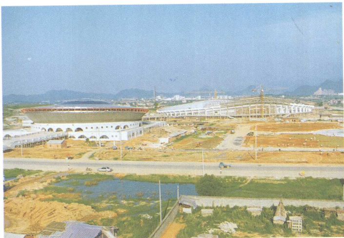
正在建设中的宜春体育中心
