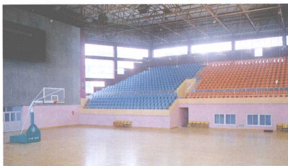
新建的宜丰室内体育馆
