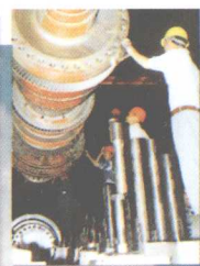
汽轮机中压转子吊装
