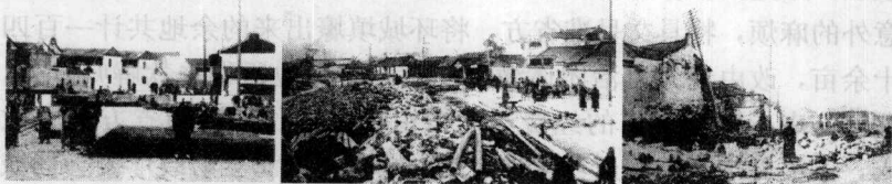
一组拆城墙照片
