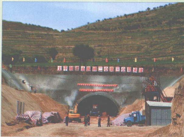
平定高速公路隧道建设
