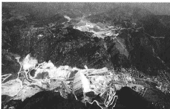
图-13 桐柏抽水蓄能电站上、下库区(2004.11 航拍)
