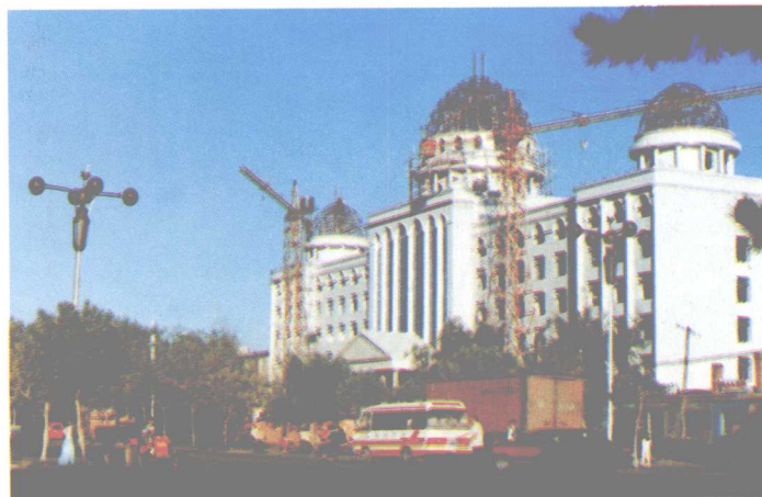
建设中的白城市中级人民法院大楼
