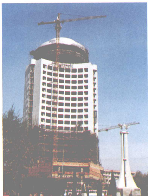
建设中的白城电业大厦
