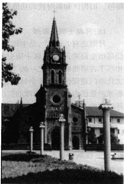
整治之后的外马路天主堂街区
