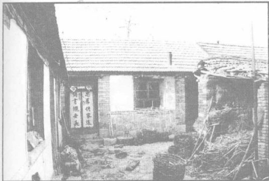
► 日新堂花园东群房外墙特写
