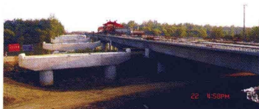
彩图 12 架梁施工
