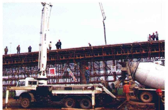
彩图 8 天桥梁体现浇施工现场
