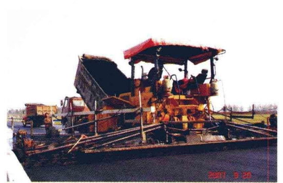
彩图 10 沥青路面摊铺
