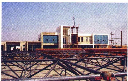
彩图 13 收费站施工
