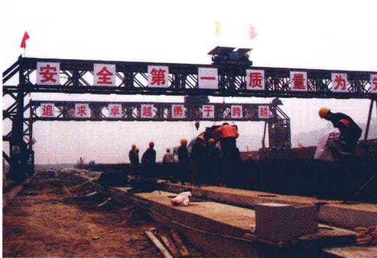
彩图 7 预制梁施工现场
