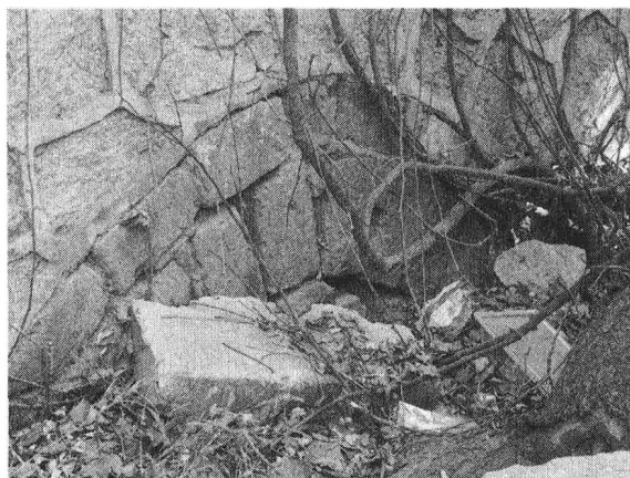
图 16-2 簏兜桥进水口水关
