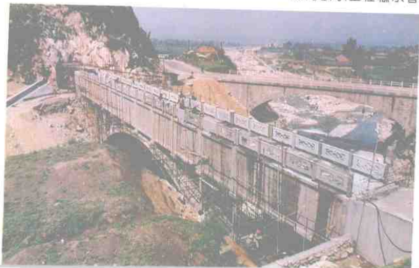
黑河引水工程输水管线的泮河渡槽 梁 斌 摄
