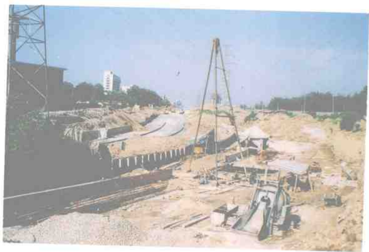
南二环路工程施工 现场
