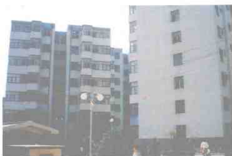
新建成的低洼改造工程之一 —— 保吉巷住宅小区
