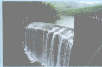
竹洋水库大坝
