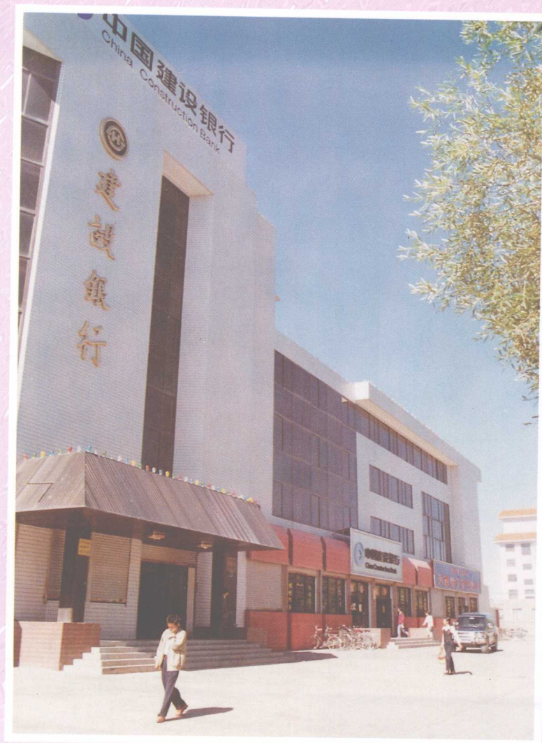
中国建设银行海西州中心支行
