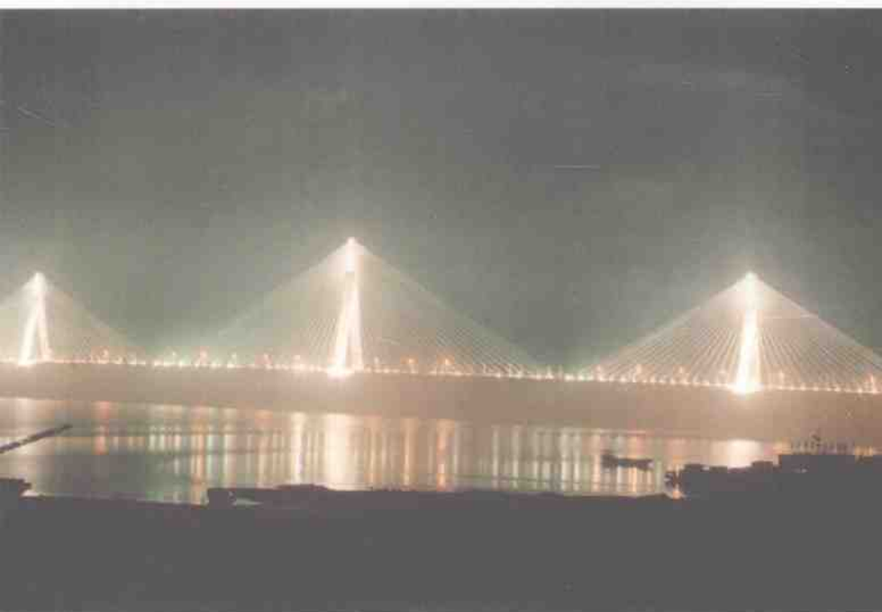
岳阳洞庭湖大桥
