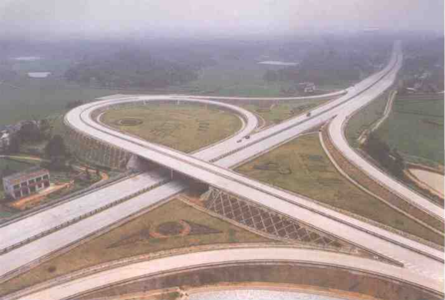
长常高速公路金桥互通立交桥
