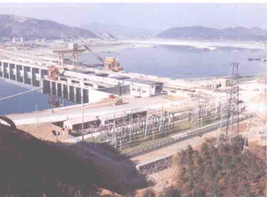
湘江大源渡航电枢纽一期厂坝电站开关站全貌
