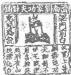
● 这是一块非常成功的招贴广告实物（图 2.1）
