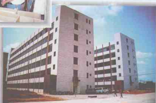
柳州高新技术开发区已建成的通用工业厂房。
