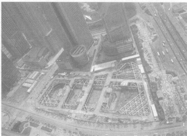
图2 平安金融大厦基坑实景图
