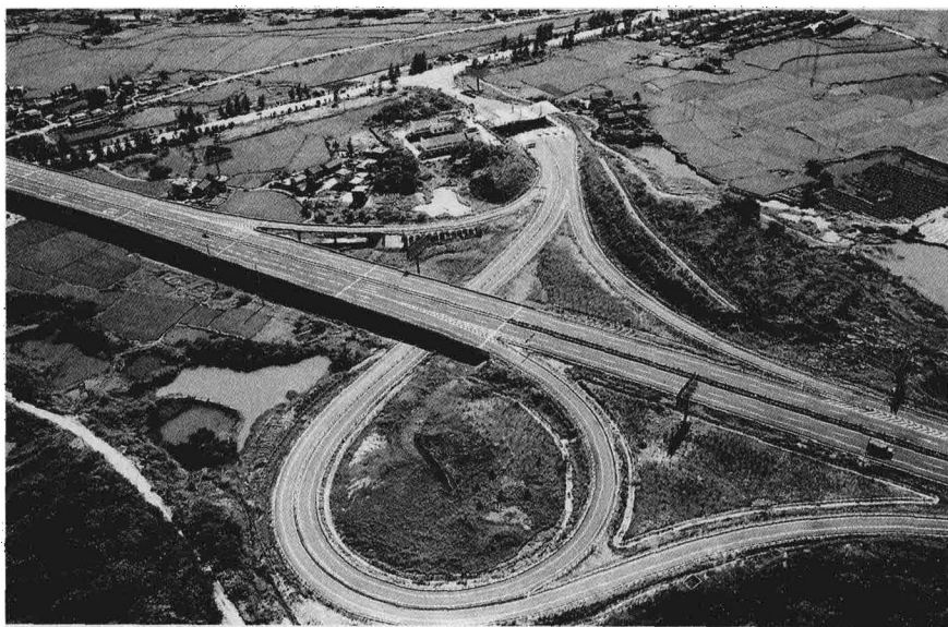
图2 穿越当涂县境内的芜马高速公路
