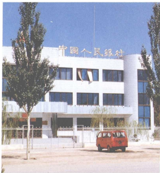
人民银行办公楼
