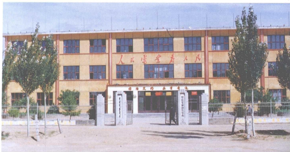
旗农电局办公楼
