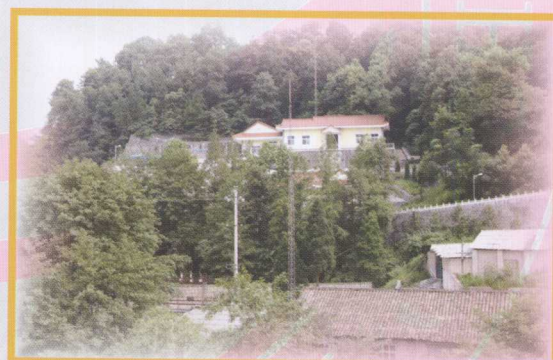
1964年10月投产发电的七里坪电站，装机 2 \times 160 千瓦，是建始县第一座县级水电站。
