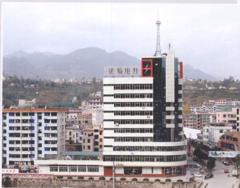
1999年落成的建始县电力公司调度综合楼
