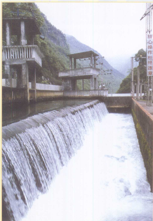
20世纪建成的野三河一级电站，装机 2 \times 1600 千瓦+ 1 \times 1580 千瓦，是建始县电网的骨干电源点之一，长期担任县电网的调频任务。
