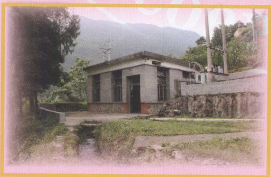
建始县最先建成的乡村电站——三里老村电站，装机 1 \times 200 千瓦，于1964年4月投产。
