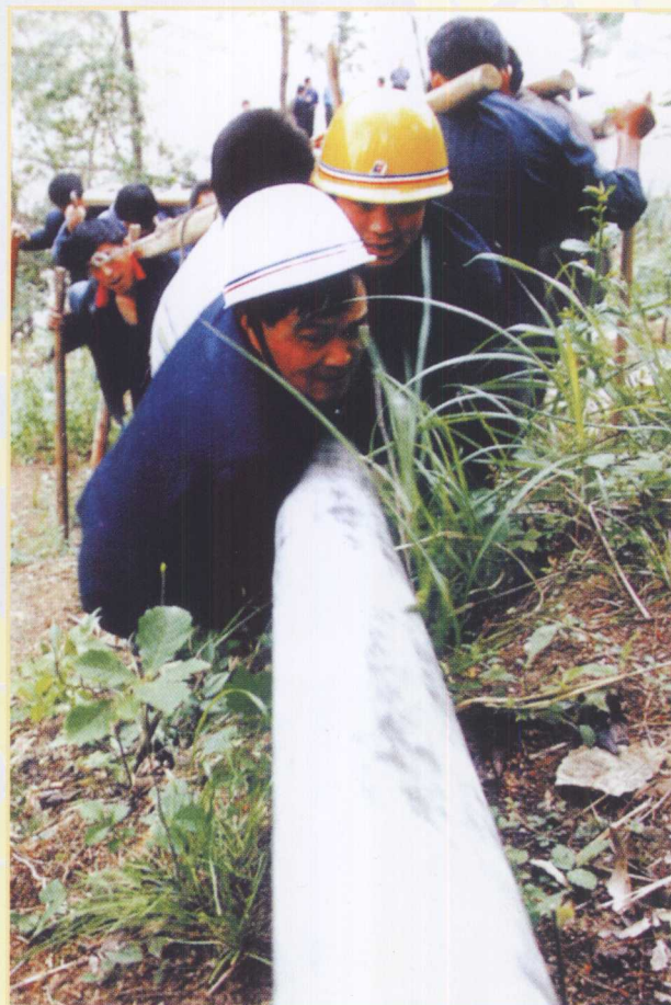
1999—2003年开展的农村电网建设改造，投入资金1.47亿元，使建始县电网得到彻底改造。右图为红岩镇凉水埠村施工现场。
