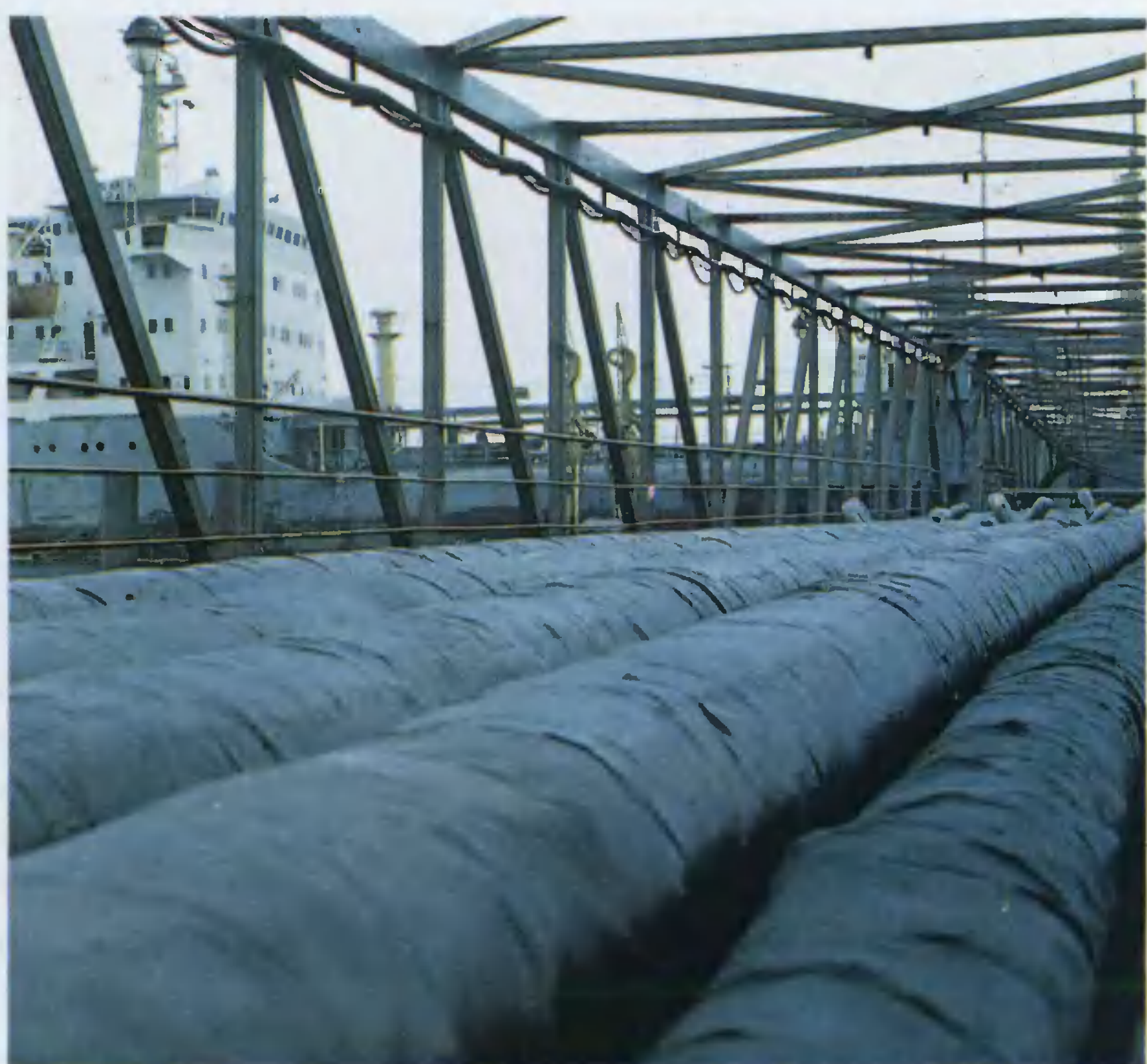
江畔油龙—鲁宁输油管道
