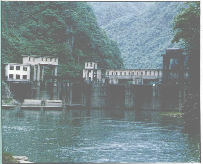
省属渔子溪电站水闸
