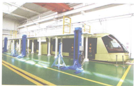
● 津滨轻轨车辆段停车库
