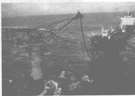
图 1-11 铰接塔单点系泊生产系统
