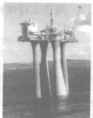
图 1-6 多腿混凝土平台
