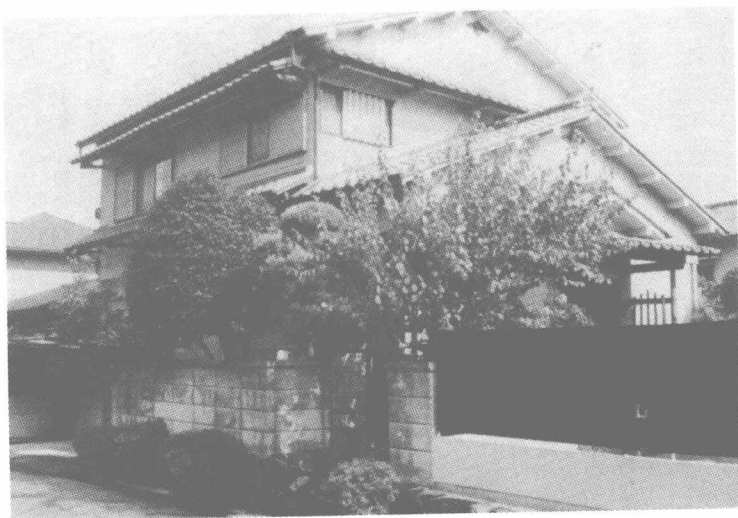
图4 在平房的工业化装配式住宅上加建传统的木造二层部分
