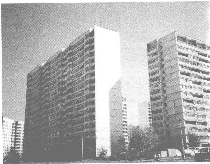
图 1-1 莫斯科市内运用大型板式构法建造的住区
