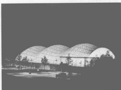
图 2-3 纤维及纸质膜构成屋顶
