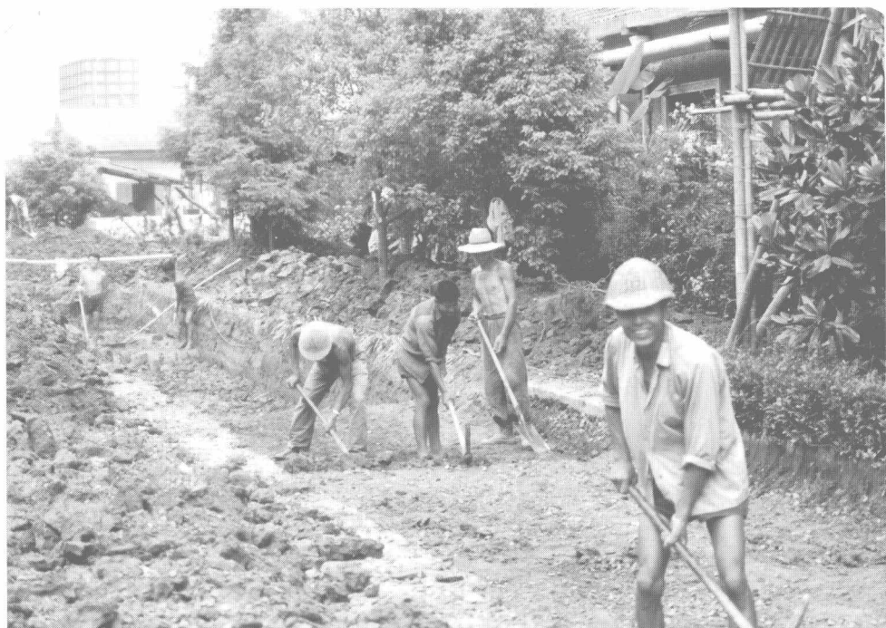
冲压车间扩建项目土建施工。
