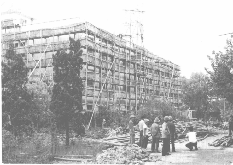
办公楼修缮，摄于1986~1987年。
