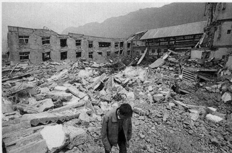
震后,残垣断壁
