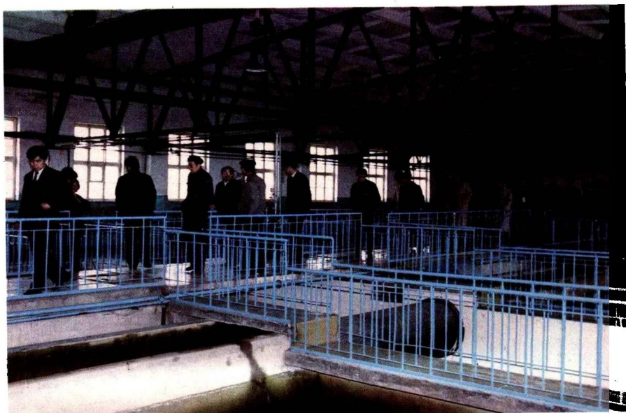
建成后的中日人民 友好水厂第二净化系统 8 000平方米净水车间
