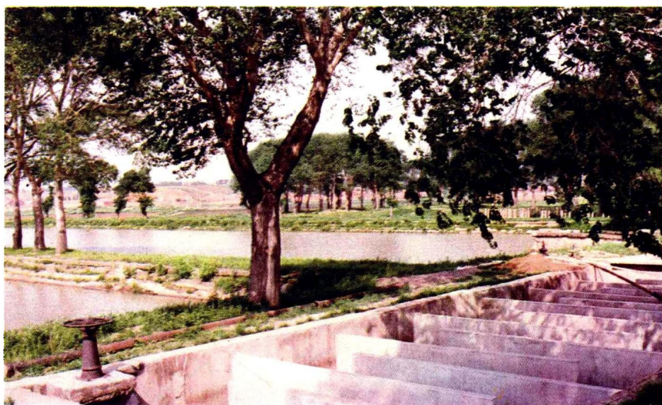
建成于 1987 年的南岭水厂北山 露天沉淀池，日沉 淀能力 5 万立方米
