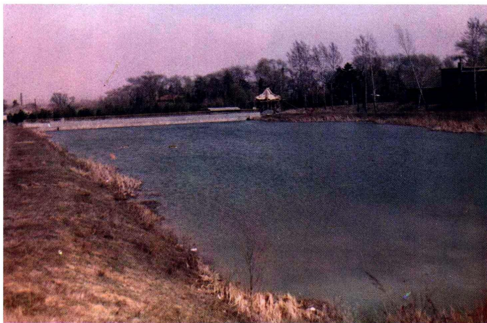
建成于 1987 年的南岭水厂北山 露天沉淀池，日沉 淀能力 5 万立方米
