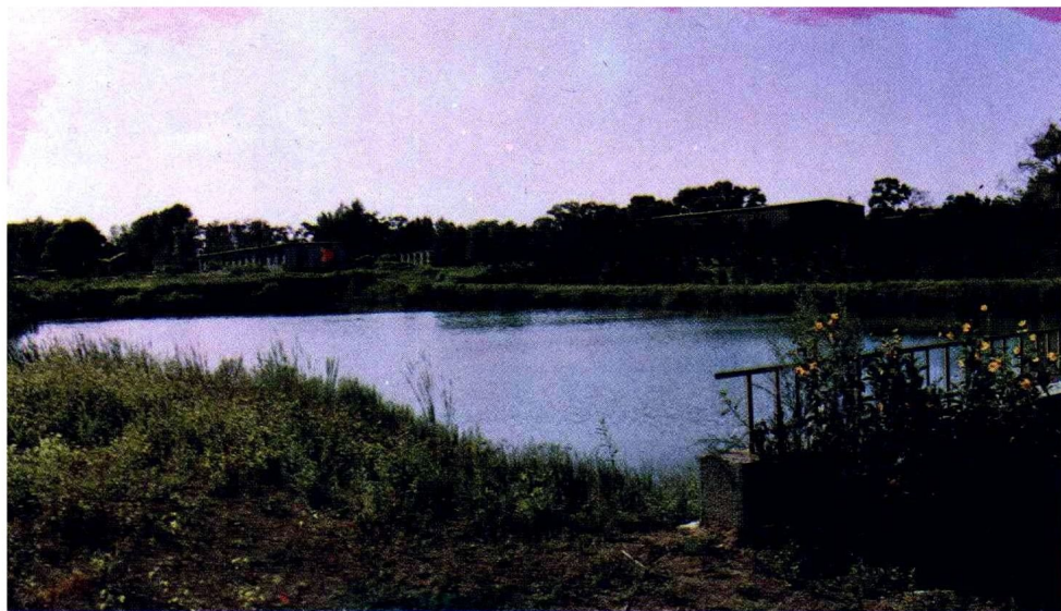
南岭水厂南山 露天沉淀池
