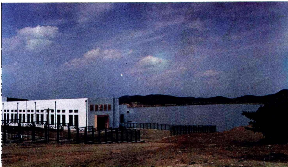
石头口门水库取水 泵站
