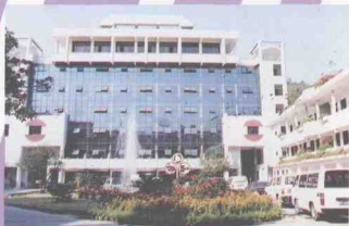
桂林地区行政公署办公大楼
