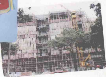
新建的综合楼
