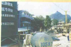
散装水泥车在建筑工地卸料
