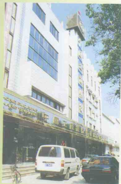
使用本公司散装水泥的建筑物
