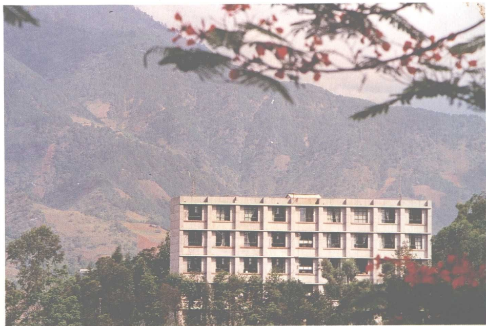
2. 绿树环抱中的怒江州林业局办公楼
