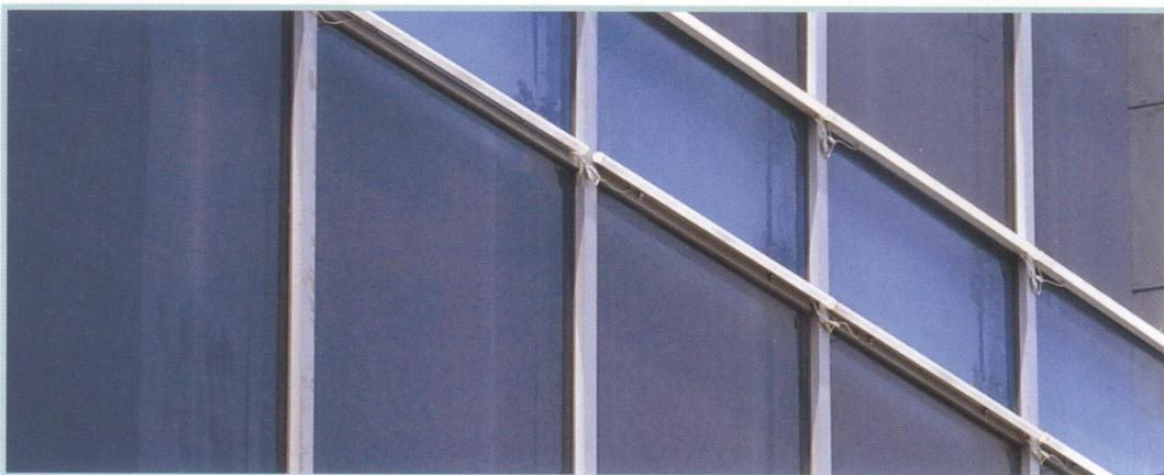
玻璃是由石英砂、纯碱、长石及石灰石等主要原料经高温制成的，是熔体在冷却过程中黏度逐渐增大而获得的不结晶的固体材料。性脆而透明。玻璃由于其透光性、平整性等诸多特点，帮助建筑师实现打破传统砖石建筑封闭形象的梦想，从而成为现代三大建筑材料之一。
