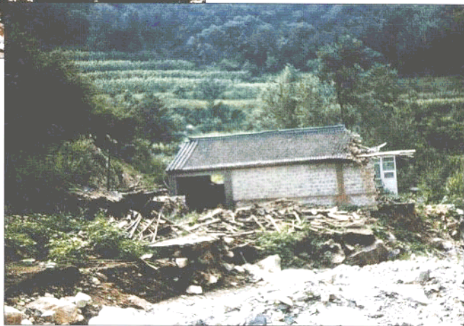
1991年6月10日四合堂乡张家沟遭受洪水、泥石流灾害的情形
