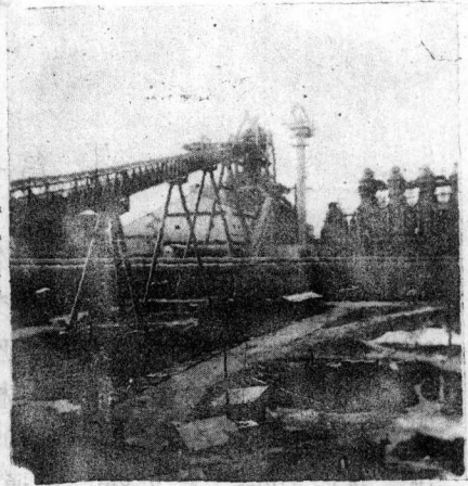
图 1-2 宝钢 1 号高炉和上料通廊
