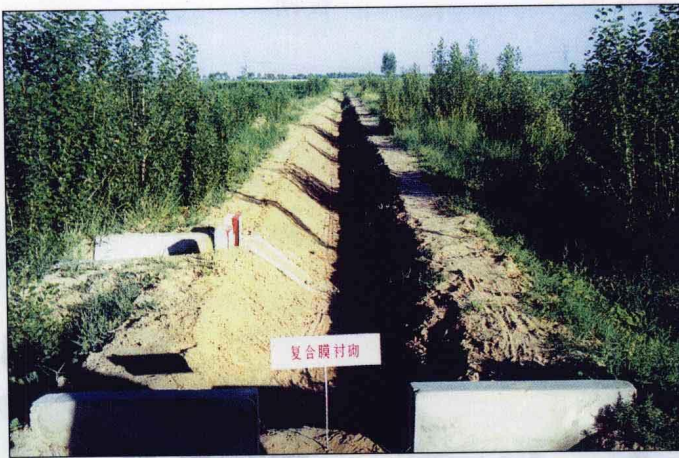
包头市土右旗采用复合膜衬砌渠道
