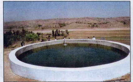
鄂尔多斯市准格尔旗开发地下水，建设高位蓄水池进行大田节水灌溉
