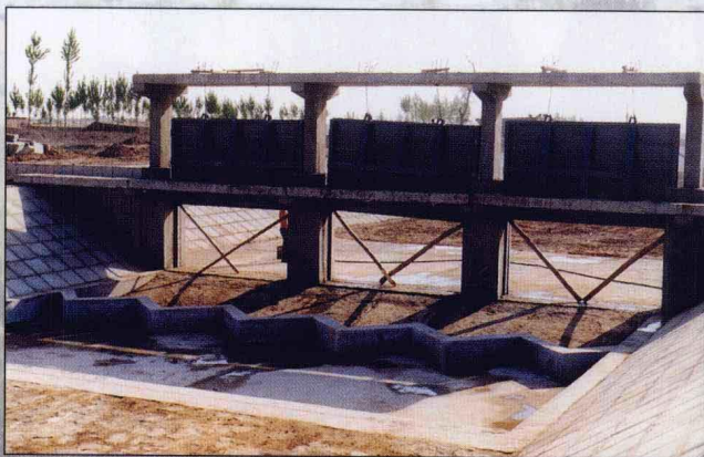
河套灌区永刚分干渠节制闸W形消能工程
