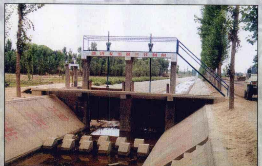
河套灌区支渠节制闸
