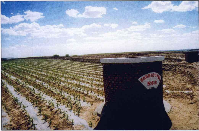
呼和浩特市清水河县集雨工程配水池自压滴灌
