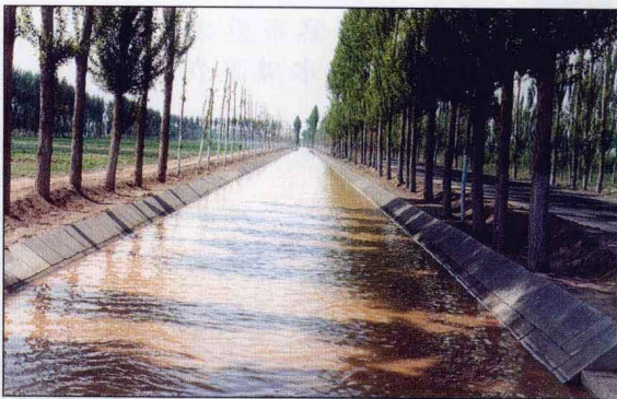
临河市隆胜西济支渠采用混凝土板、复合土工膜衬砌渠道
