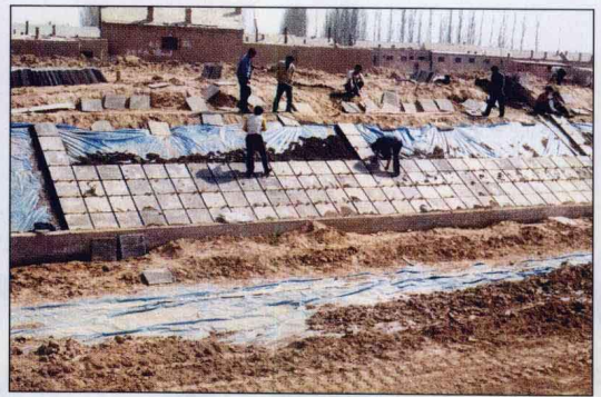
河套灌区永刚分干渠采用复合膜、混凝土板衬砌渠道施工现场
