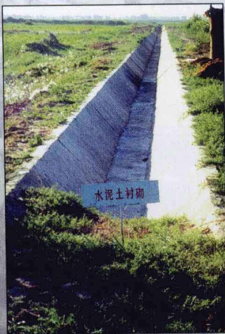
包头市土右旗采用水泥石衬砌渠道
