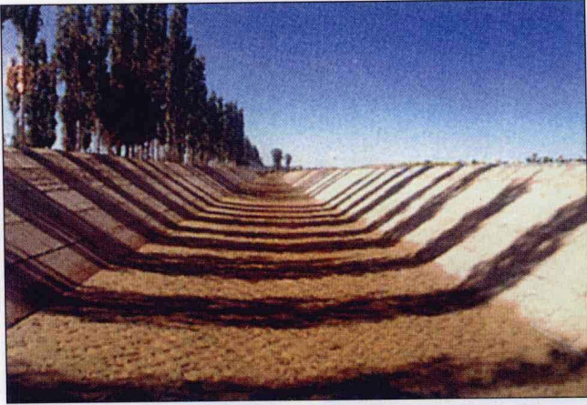
河套灌区采用土壤固化剂防渗衬砌渠道
