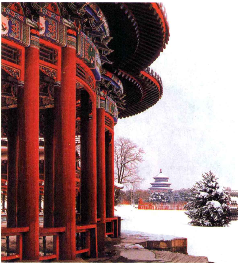
天坛双环亭梁柱
