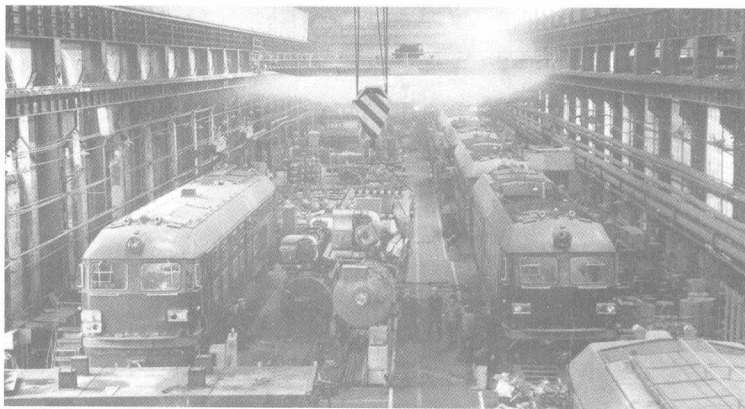
大连 机车车辆 厂内燃机 车总组 装车间
