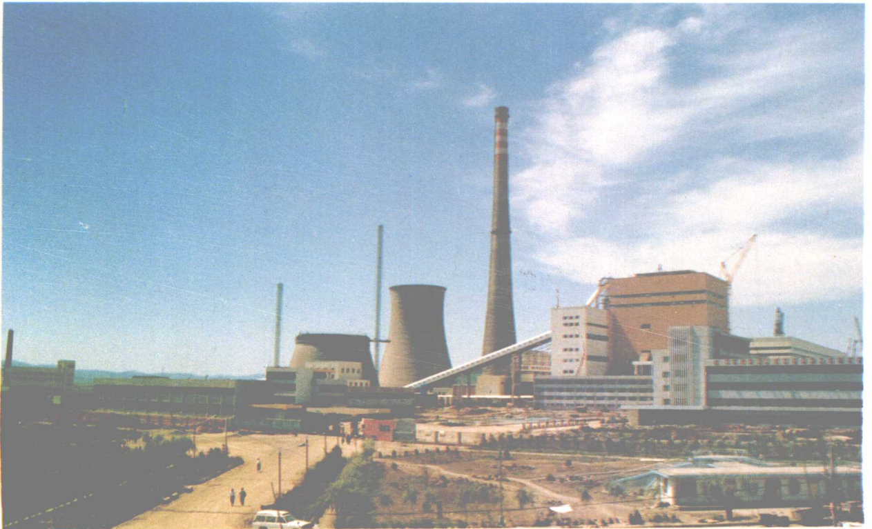
建設中的雙鴨山發電廠
