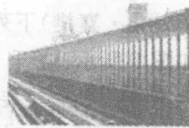
路旁安装隔音壁 D
