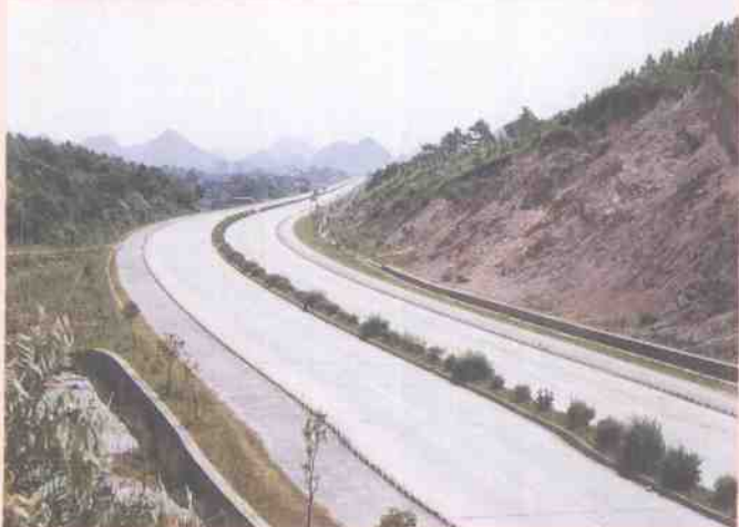
322国道桂黄一级公路
