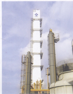
全液体空分设备 宁波隆兴6000m 3 /h
