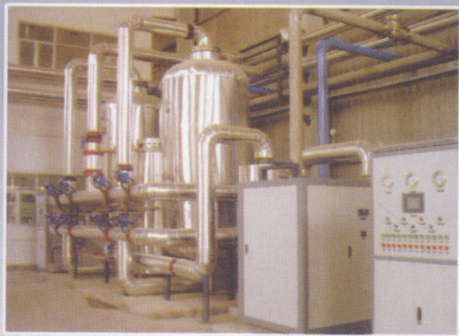
KDN-1600/70Y 型高纯氮设备预冷机组和纯化器系统及机旁仪控柜
