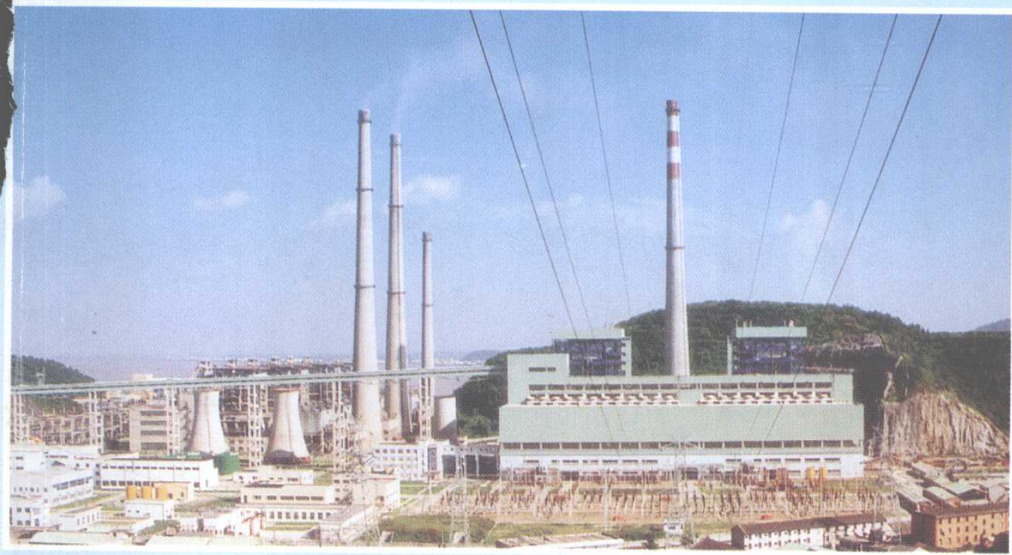
1997年12月23日，台州发电厂四期扩建工程完工。至此台州电厂总装机容量达到141万千瓦，成为我省目前最大的发电厂，并跨入我国特大型电厂行列
