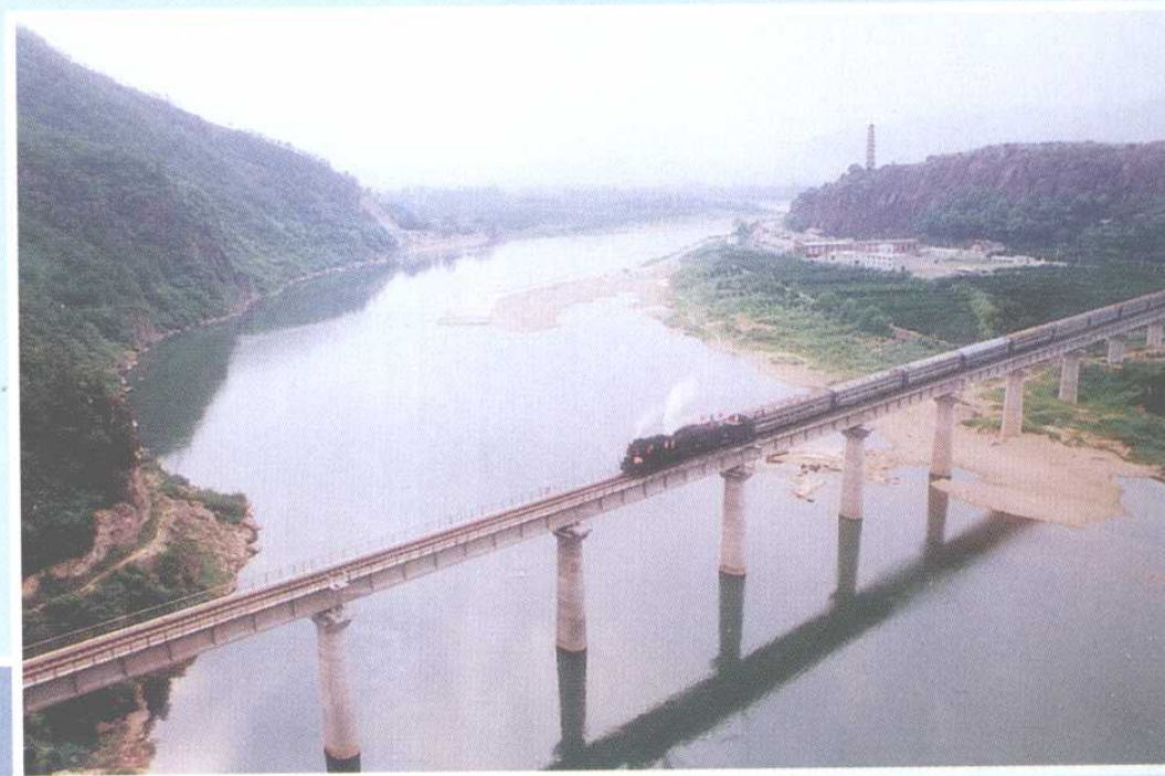
杭州——丽水列车驶经横跨瓯江的丽水小溪特大桥
