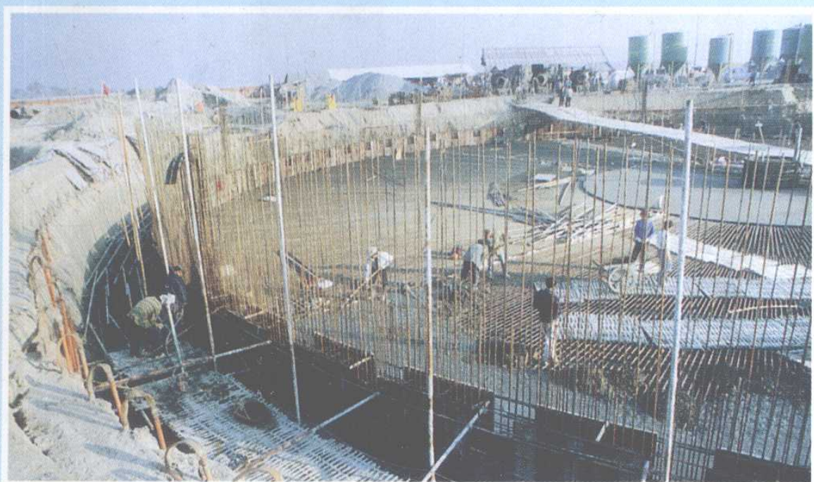
1997年7月，萧山市一项污水处理工程动工兴建，该工程今后日处理污水能力达12万吨。图为施工现场
