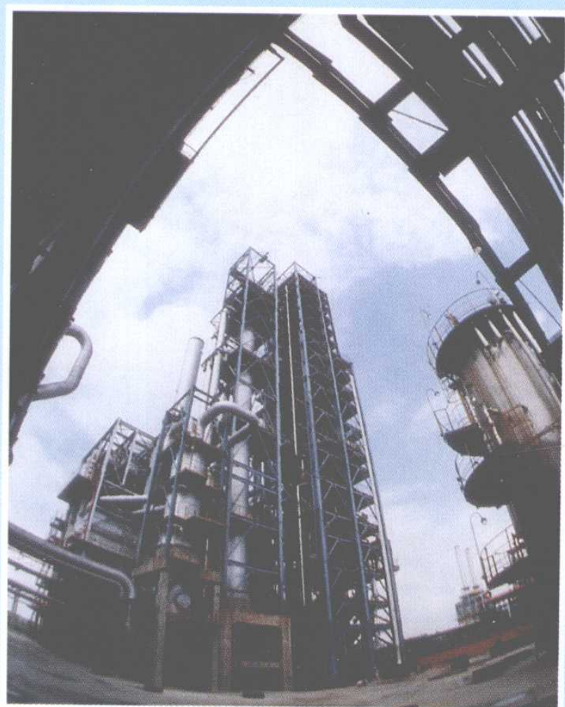
全国特大型石化企业——浙江镇海炼化1997年全年加工原油656万吨，比上年增长10.4%。图为炼化新建的炼油核心装置——80万吨炼油连续重整装置雄姿
