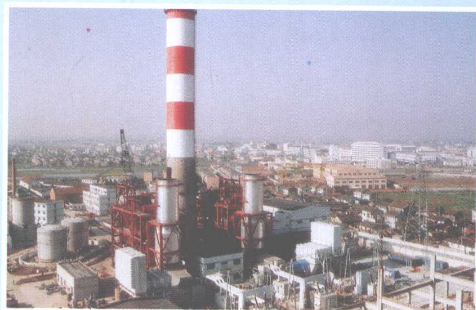
我省第一台30万千瓦联合循环燃气发电机组在宁波镇海联合发电公司基本建成
