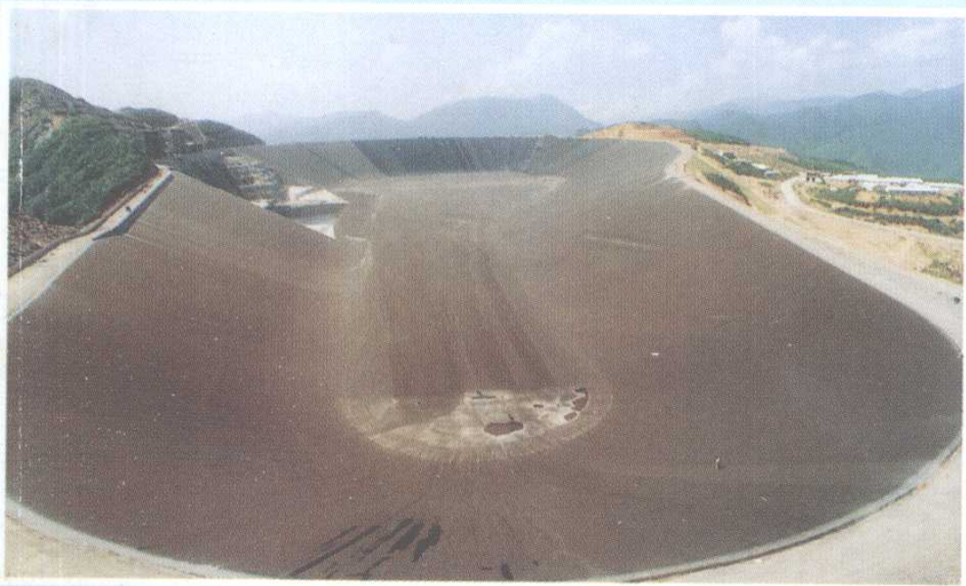
我省天荒坪蓄能抽水电站建设正紧锣密鼓进行，图为已竣工的下水库掠影
