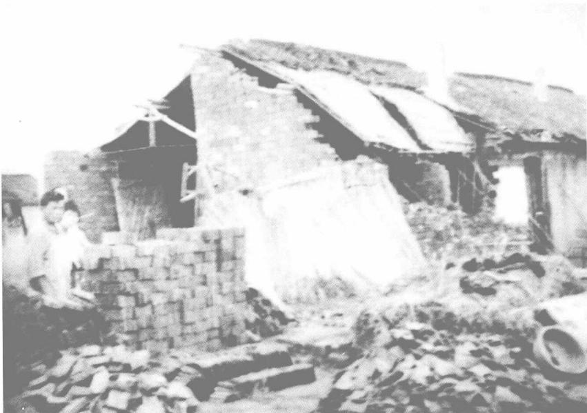
1977年9月13日，启东县受7708号台风的影响房屋受灾情况
