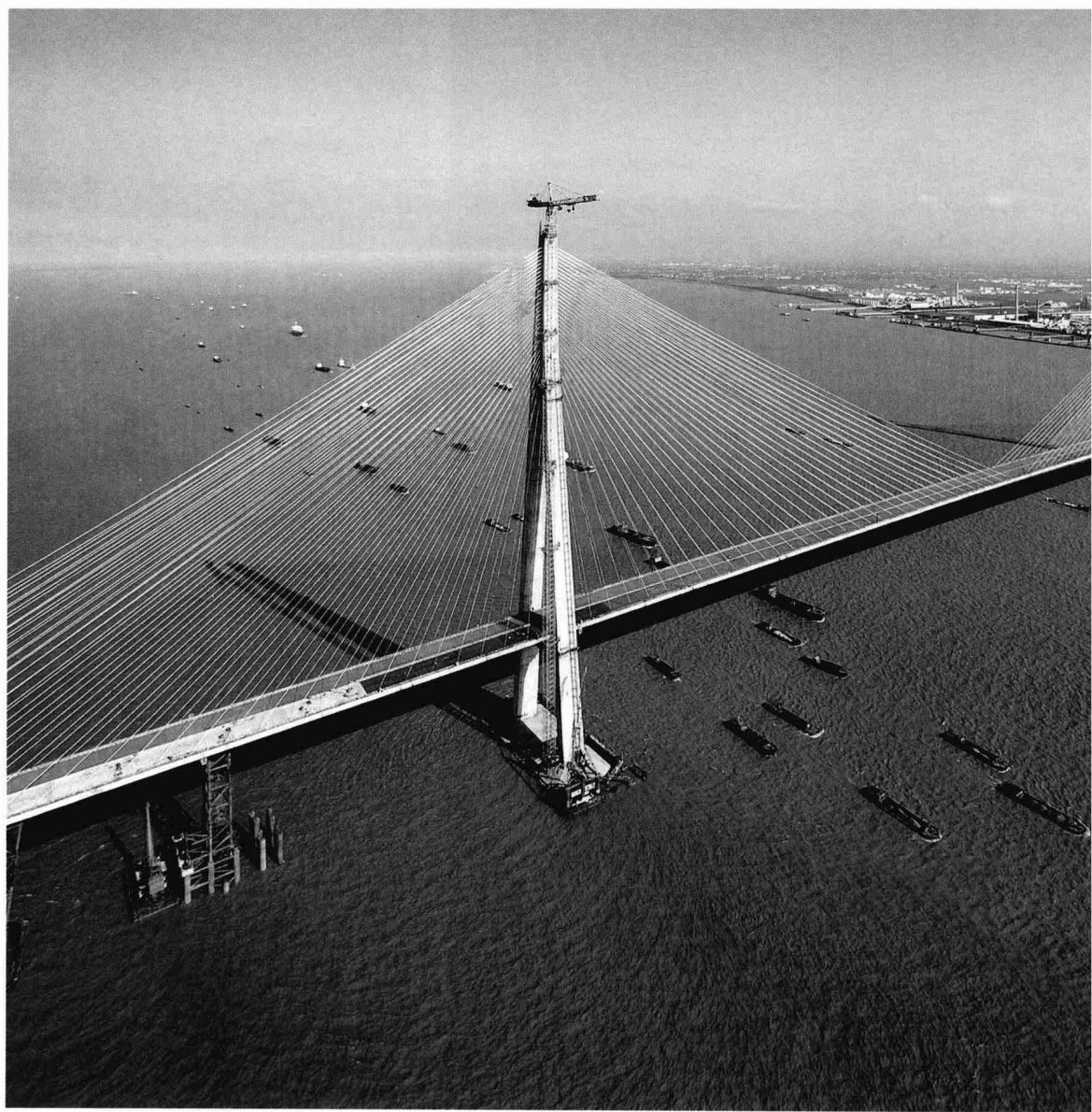
苏通长江公路大桥
