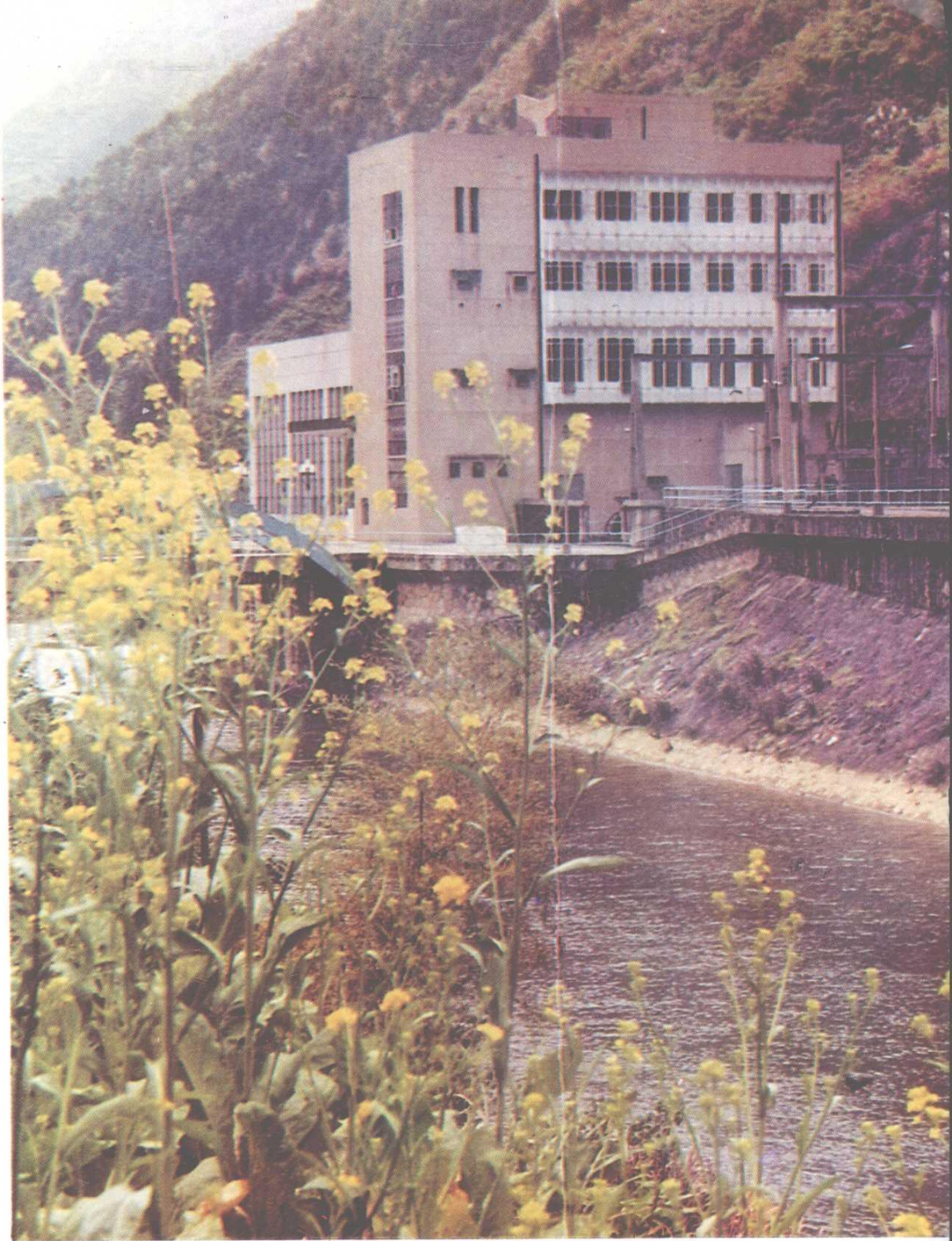
内下二级电站
