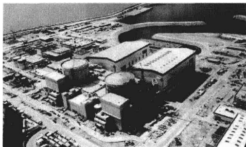
图 1-7 核电厂现场图
