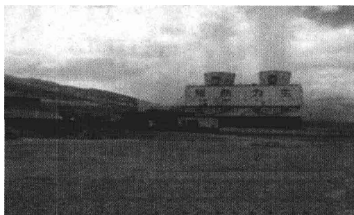
图 1-8 地热电厂现场图
