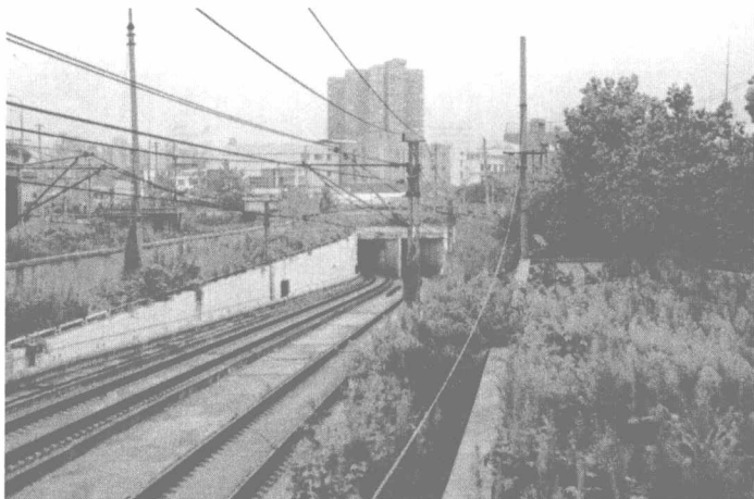
图 1-2 漕宝路站—上海南站站区间洞口
