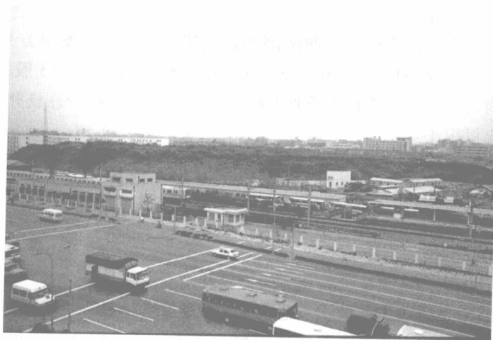
图 1-1 既有一号线上海南站地面站
