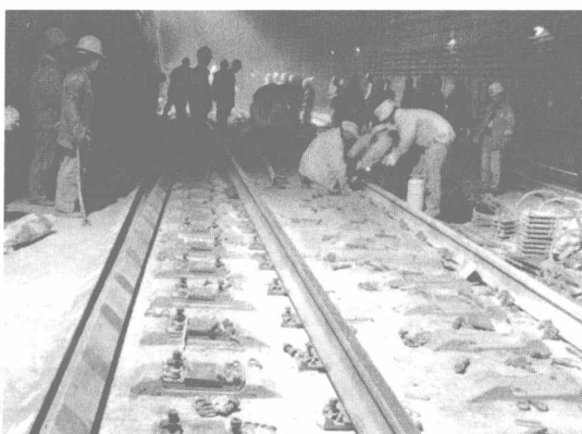
图 1-6 正线整体道床轨道拨接施工
