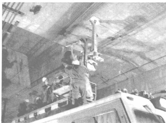
图 1-5 正线接触网拨接施工
